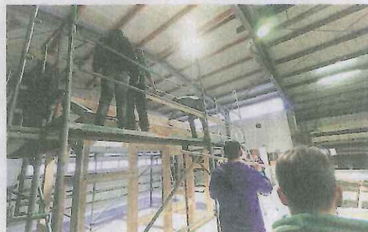
Das Gerüst für den Unterstand steht. Später folgen die Dachschalung und die Unterkonstruktion für die Dachziegel.
