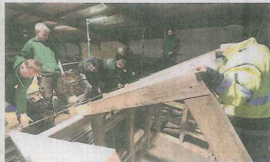
Maßarbeit: Der Unterstand für den Sportplatz nimmt langsam Form an.
