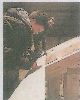
Die Holzbalken werden von massiven Nägeln gehalten.
